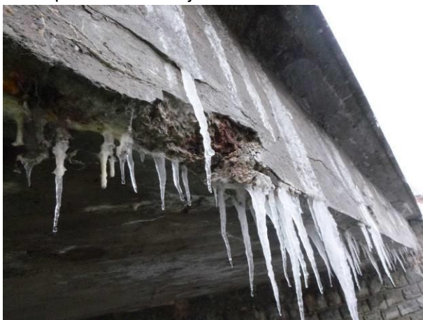
Pohled na boční stranu desky při výtoku, kde zřejmá nefunkčnost zakončení říms okapovým nosem. Struktura betonu je silně porušená s vysokou vlhkostí, kde při zmrazovacích cyklech dochází k rozpadu betonu.
