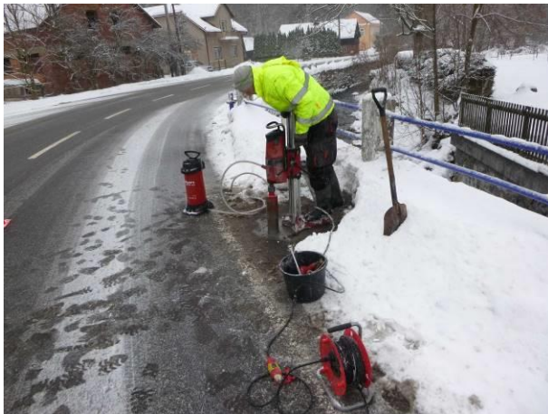
Pohled na provedení vývrtu na pravé polovině u OP2.
