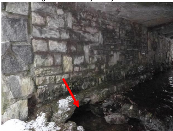
Pohled na pravou stranu dříku OP1. Viditelné kamenné haklíkové zdivo. Je vidět podemletí ochranných prahů.
