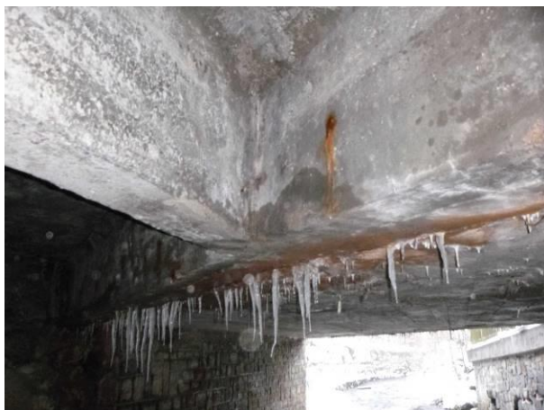
Pohled na silné zatékání mezi levou a pravou částí konstrukce (trámy/deska).
