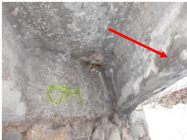
Pohled na silnou degradaci krajního trámu u OP1. Viditelné výluhy z betonu a viditelné trhliny na trámu.
