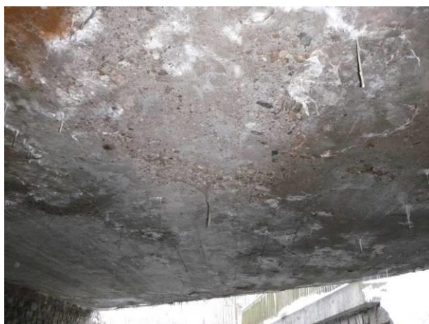
Detailnější pohled na desku. Viditelné výluhy ze zatékání. Výskyt mnohočetných trhlin.
