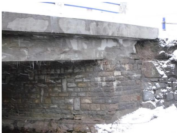
Pohled na pravou stranu dříku OP2, které je tvořeno kamenným haklíkovým zdivem.
