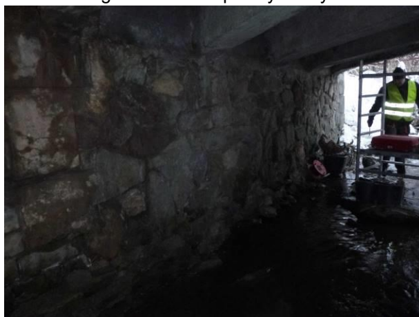
Pohled na levou stranu dříku OP1. Původní část tvořená kamenným zdivem.
