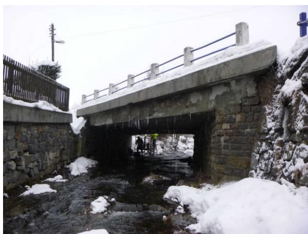
Pohled na konstrukci mostu ze strany výtoku. Viditelná degradace boční plochy desky.
