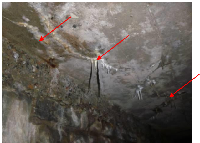
Pohled na trhliny v desce přes které evidentně zatéká.
