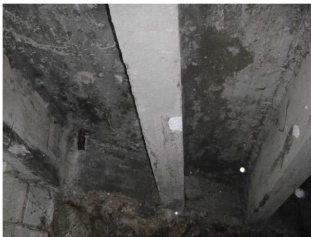
Pohled na zatečenou konstrukci trámů desky vetknutých do ztužidel nad podporou.
