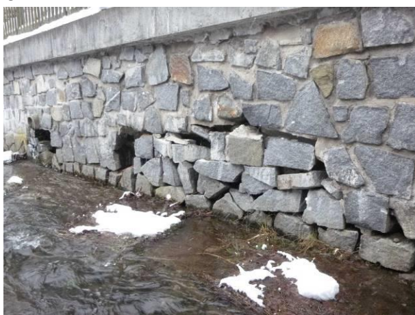
Pohled na zeď u OP1 vpravo ve směru staničení (strana výtoku). Viditelné volné kamenné bloky.
