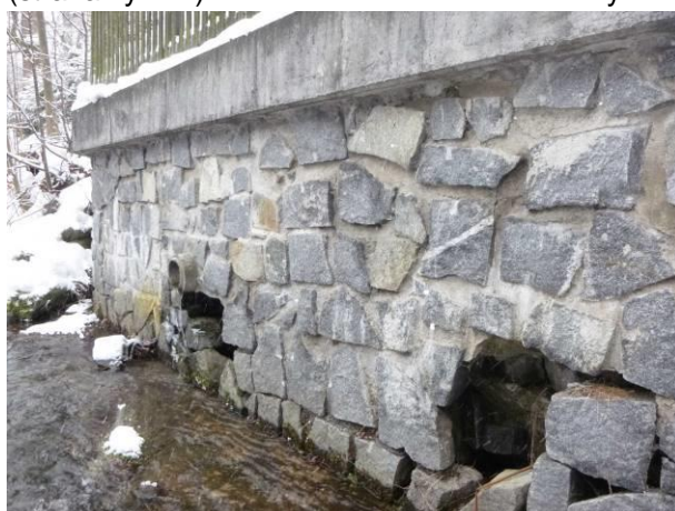
Konec zdí u OP1 vpravo ve směru staničení (strana výtoku). Viditelné volné a chybějící kamenné bloky.
