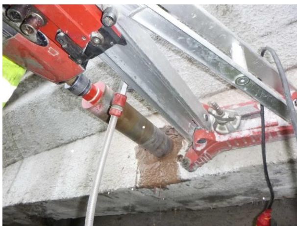
Pohled na jádrové vrtání do železobetonového trámu.
