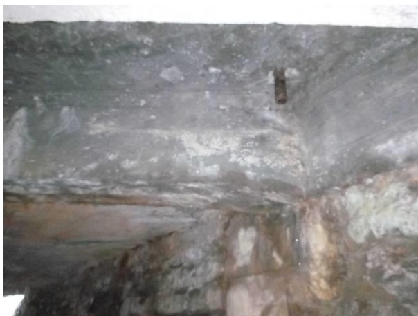
Pohled na silně zatečený vnitřní trám u OP1. Je zde viditelný zřejmě nefunkční svod z NK.
