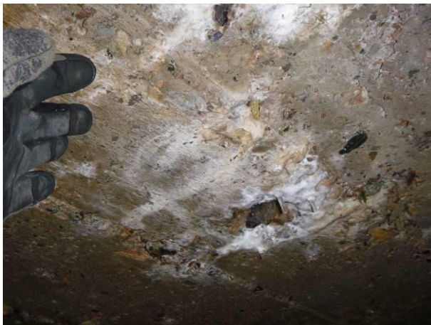
Pohled na strukturu se střerkovými hnízdy, kde beton postrádá tmel a jemnou složku kameniva.
