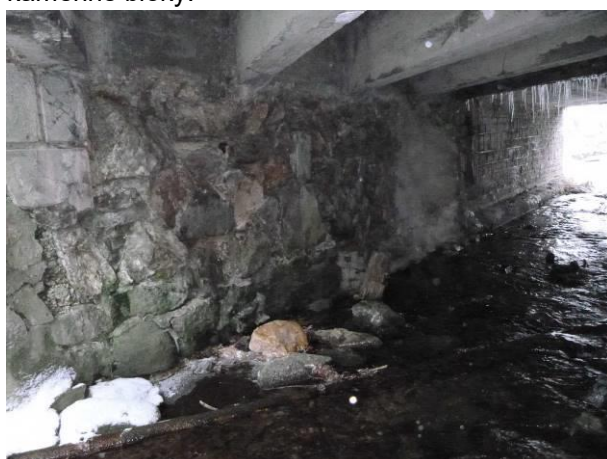
Pohled na levou část OP2 tvořené kamenným zdivem.
