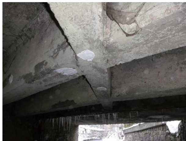
Pohled na křížení podélných trámů se středovým příčným trámem.
