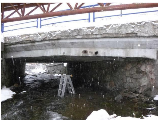
Pohled na konstrukci mostu ze strany vtoku. Viditelná degradace omítky římsy.
